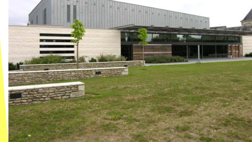
Salle Multimédia de Lençloître
